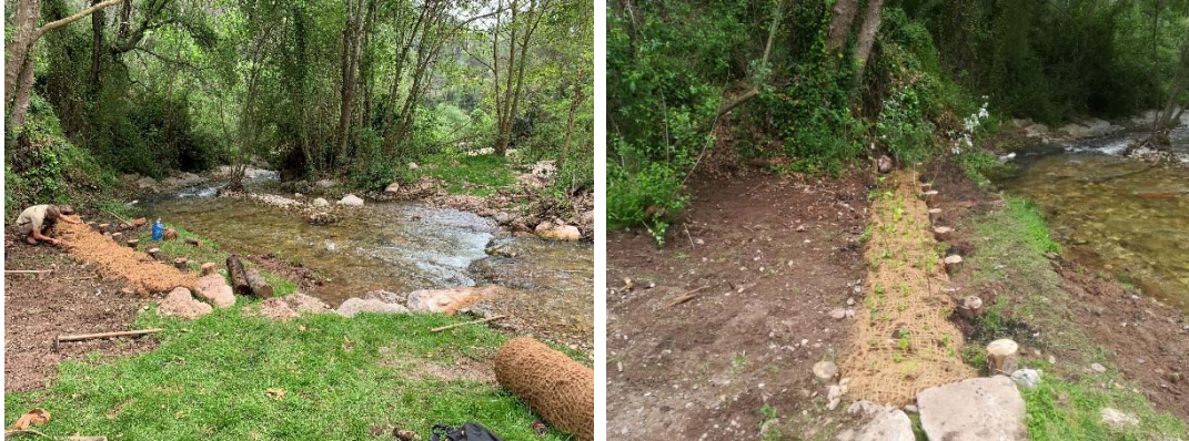
Imatges de l'estructura J-Vane finalitzada
