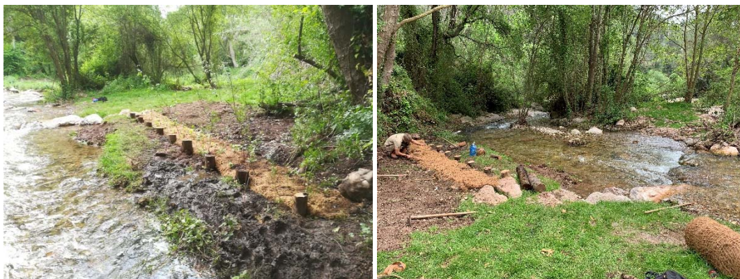
Imatges d'una estructura tipus Vane
