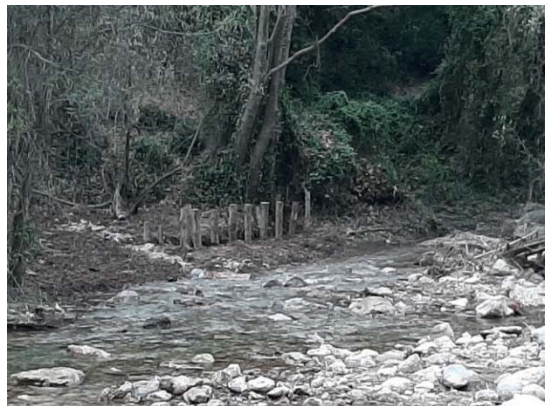
Imatges de la construcció de la recta del deflector
