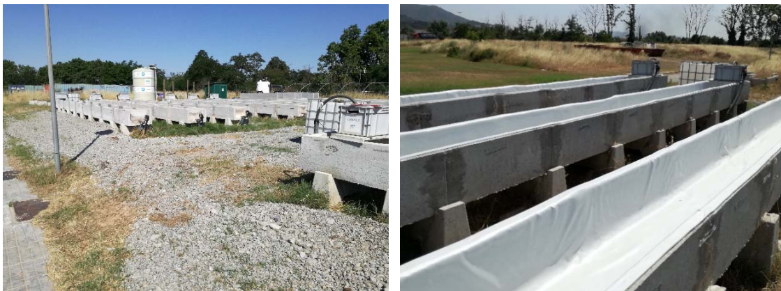
Nuevo sistema de impermeabilización de los canales del URL
