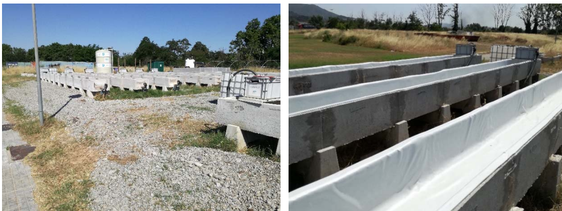
Nou sistema d'impermeabilització del canals de l'URL
