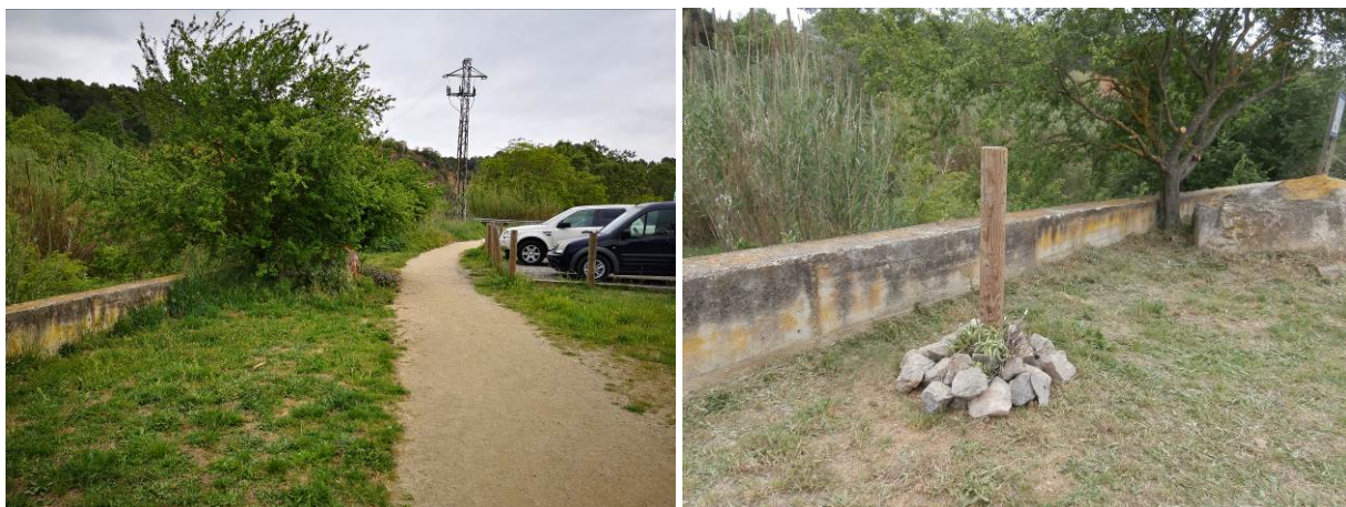
Antes y después del margen del camino con la zona de refugio construida.
