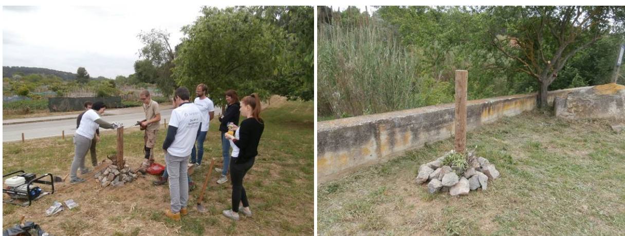
Procés constructiu al a zona 1 / Zona de refugi acabada a la Zona 2
