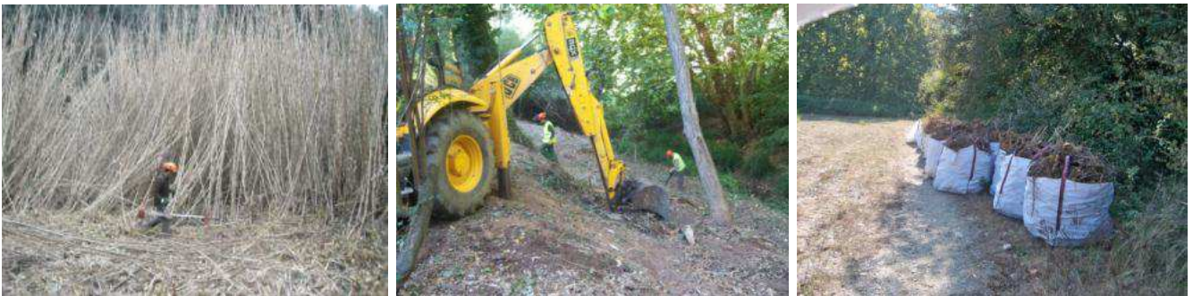
Imágenes del estado inicial de la riera, el proceso de eliminación del rizoma con retroexcavadora y el ensacado para poder retirarlo del cauce.
