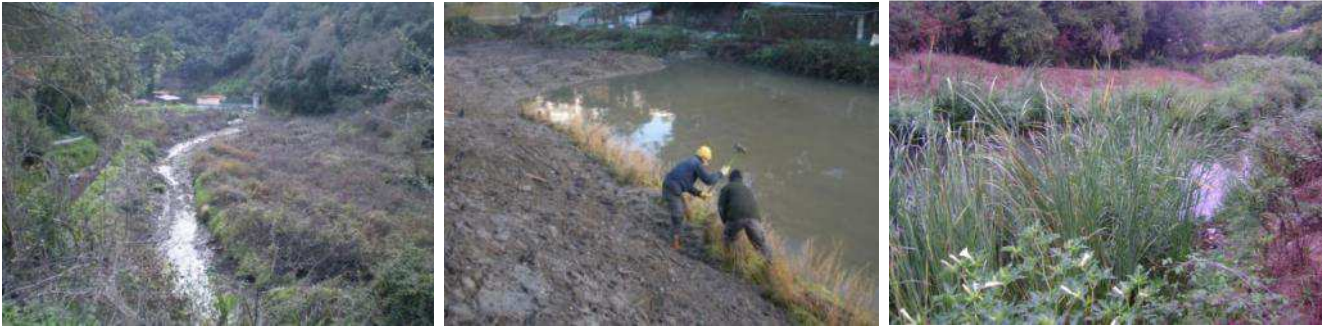
Se utilizaron herbazales estructurados en fibra de carrizo y enea en un 50% de los márgenes. El espacio fue totalmente colonizado después de 2 años.
