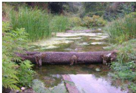
En este caso se utilizó un árbol caído cerca de la zona para crear un pequeño dique que permitió la creación de la balsa temporal.
