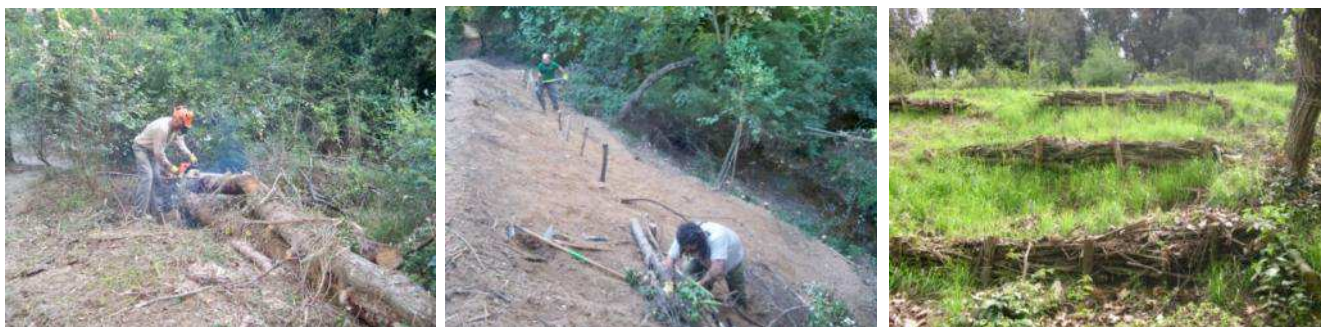
Las fajinas ayudan a la consolidación del talud y a la conservación de la humedad para un mejor desarrollo de la vegetación plantada.
