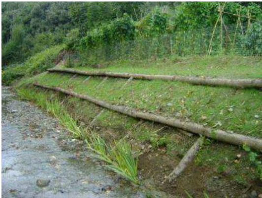
Enrejado vivo con un rol vegetalizado para proteger la base. Las imágenes muestran la actuación después de 1 mes de su finalización y al cabo de un año.
