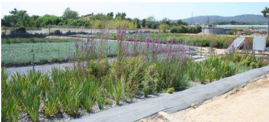
Imagen del humedal artificial construido en el vivero Sala Graupera en Sant Andreu de Llavaneres, Maresme
