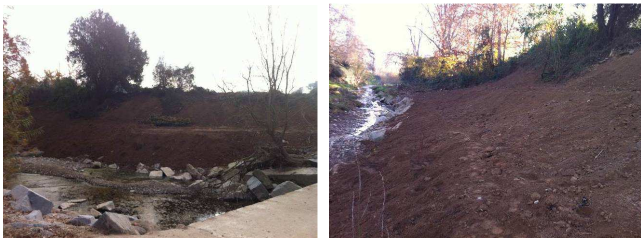
Taludes durante los trabajos de reperfilado y una vez finalizada la plantación
