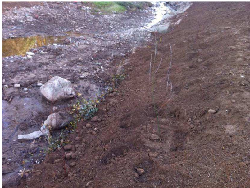
Instalación de fajina viva de sauce arbustivo en la base del talud y plantación de ejemplares de árboles y arbustos de ribera en segunda línea
