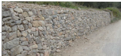
Exemple de mur de pedra seca restaurat
