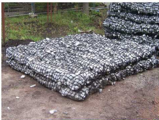
Steinmatratzen (200 x 200 cm) auf der Baustelle
