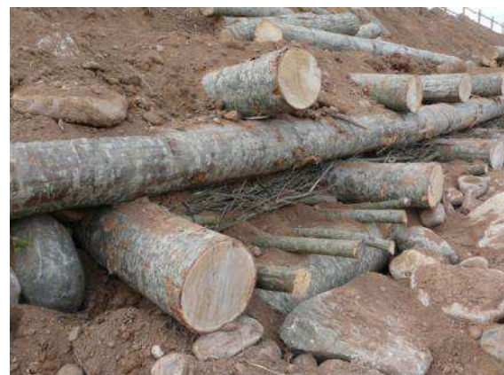
Estacas en un entramado
