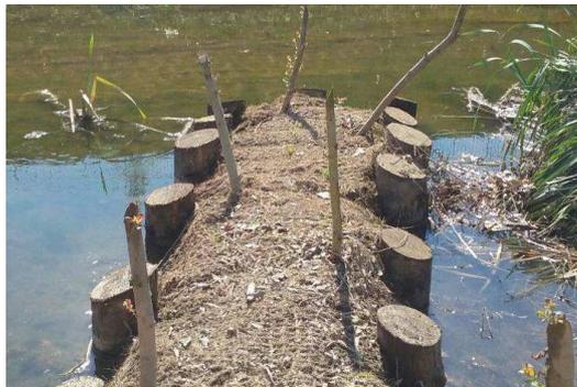
Un ejemplo de utilización de espigones es en la suavización de una curva cerrada, a fin de proteger un margen erosionado y alejar el talveg del margen del río:
