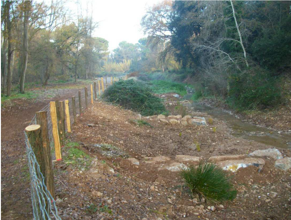
Serie de espigones para suavizar una curva. Riera de Caldes. Palau de Plegamans
