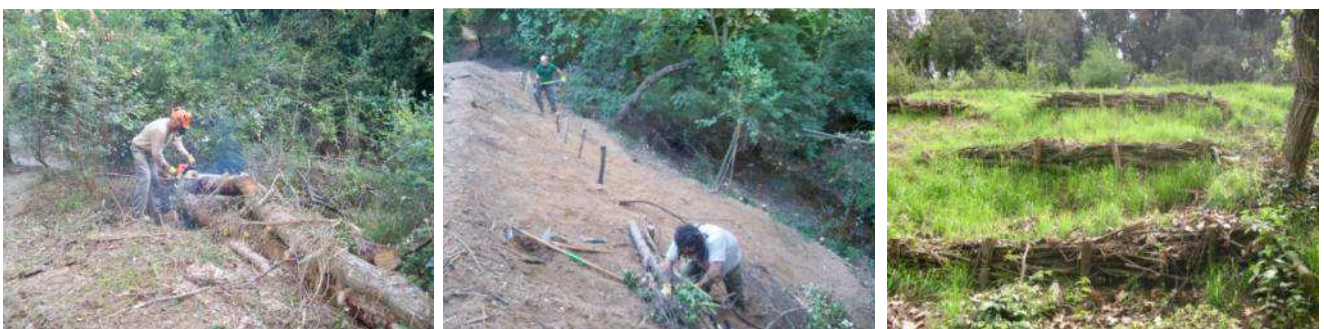
Les feixines ajuden a la consolidació del talús i a la conservació de la humitat per a un millor desenvolupament de la vegetació plantada.
