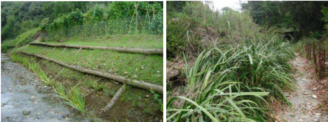
Enreixat viu amb un rotllo vegetaltitzat per protegir la base. Les imatges mostren l'actuació després d'1 mes de la seva finalització, i al cap d'un any.
