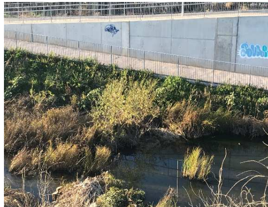
Palissada passats uns mesos després de la instal·lació
