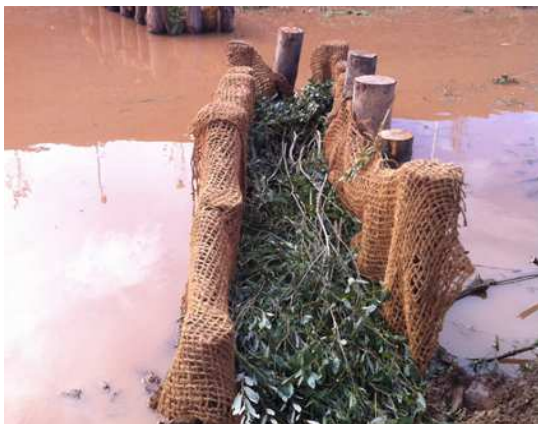
Palissada amb troca d'arbustives en procés de construcció
