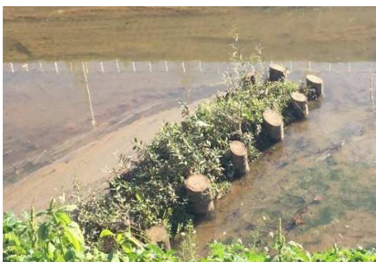
Palissada amb troca d'arbustives just acabada d'instal·lar.
