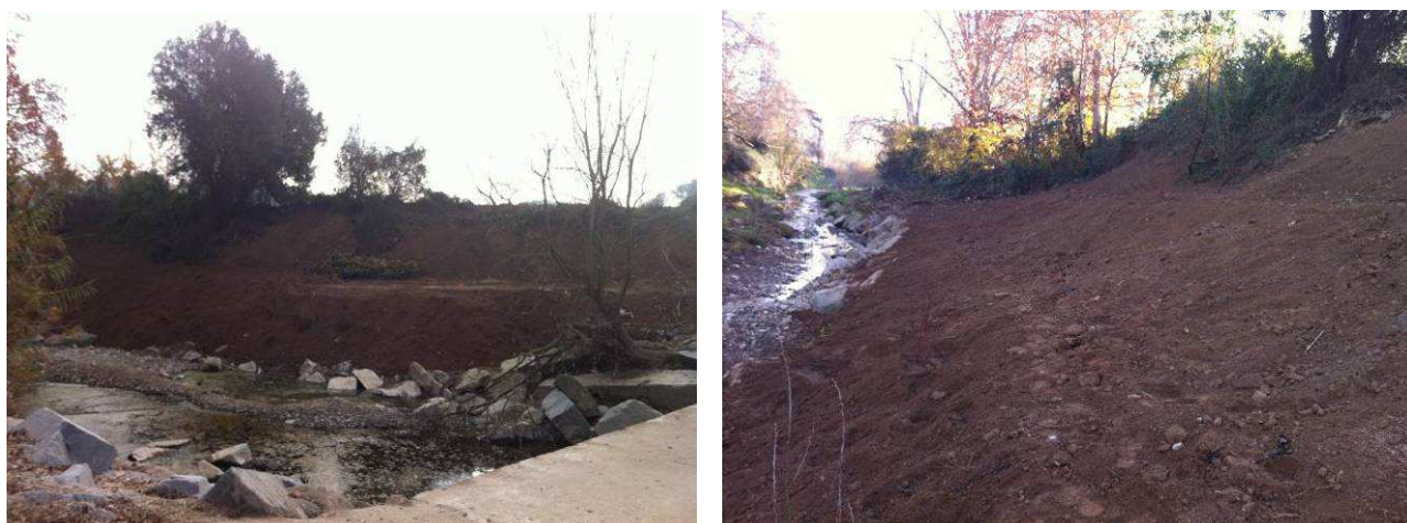
Talussos durant els treballs de reperfilat i un cop finalitzada la plantació
