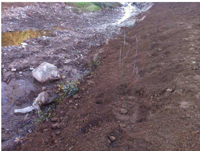
Instal·lació de feixina viva de salze arbustiu a la base del talús i plantació d'exemplars d'arbres i arbustos de ribera a segona línia
