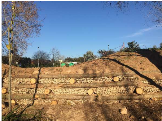
Muntatge i entramat finalitzat:
