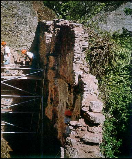
Restauració d'un mur de pedra amb morter de calç i eliminació de l'heura
