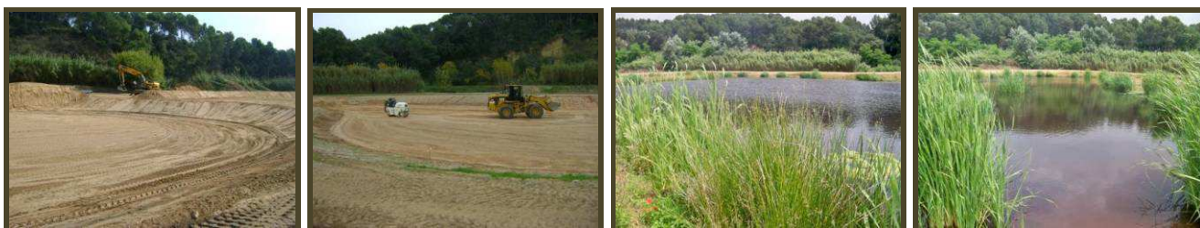
Construcció i resultat d'una bassa impermeabilitzada amb argiles.
